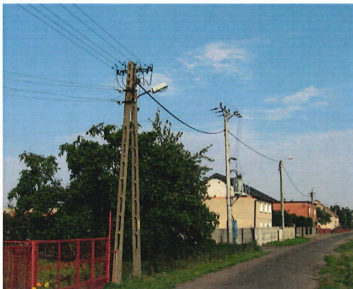
Fot. 5. Linie dystrybucyjne nn-0,4 kV (przykłady)
